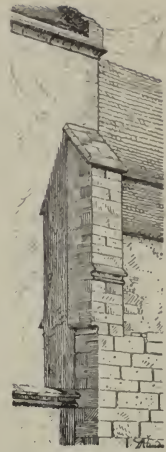
Fig. 39. Hauptkirche, Strebpfeiler zwischen Sakristei und Langhaus.
